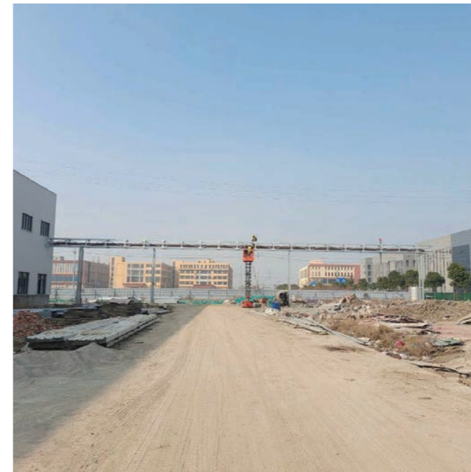
▲浙江祥恒智慧工厂一期竣工
